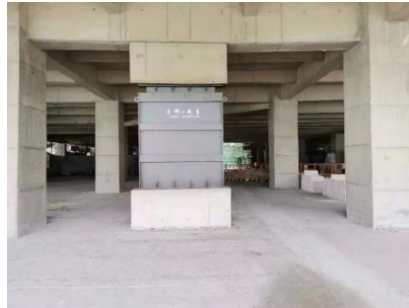
连接单元附加弯矩不可忽略的粘滞阻尼墙 (VFW)
