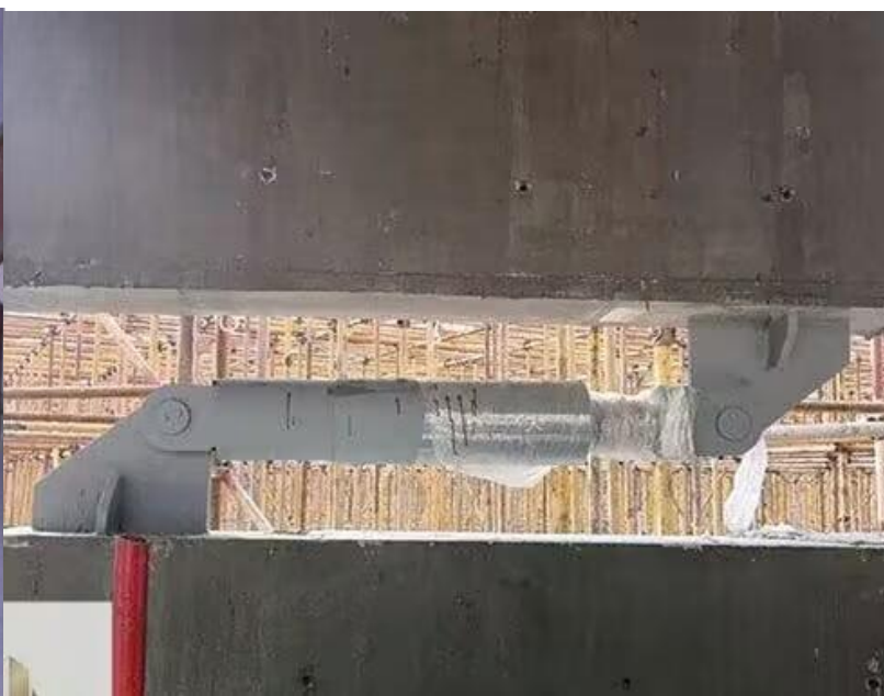
筒式黏滞流体消能器 (VFD) 墙式
