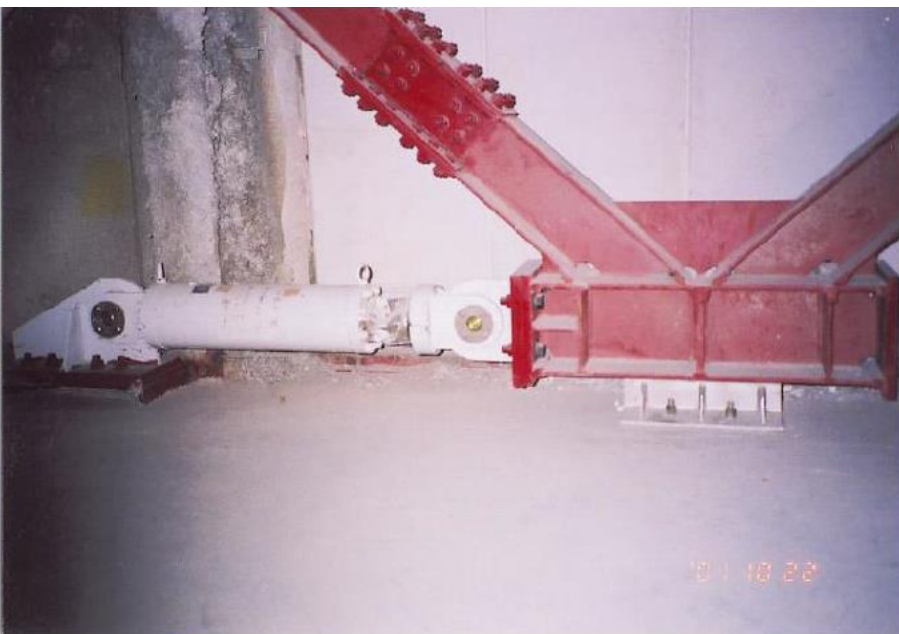
筒式黏滞流体消能器 (VFD) 支撑型
